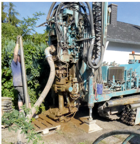
Bohrung für eine Erdwärmesonde
