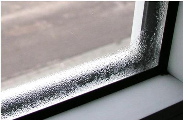
Abbildung 2: Kondensat am Rand einer Zweischeiben-Verglasung
