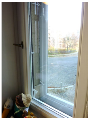
Kastenfenster (Bild: Rittersdorf)
