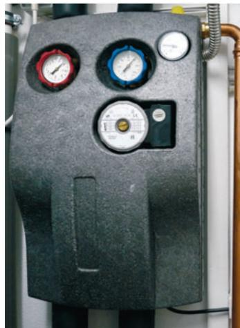
*Die Solarstation enthält Komponenten, die für den Betrieb der Anlage erforderlich sind. Dazu gehören Solarkreispumpe, Sicherheitsventile, Schwerkraftbremse sowie Rückschlagventil und Kugelhähne.*
