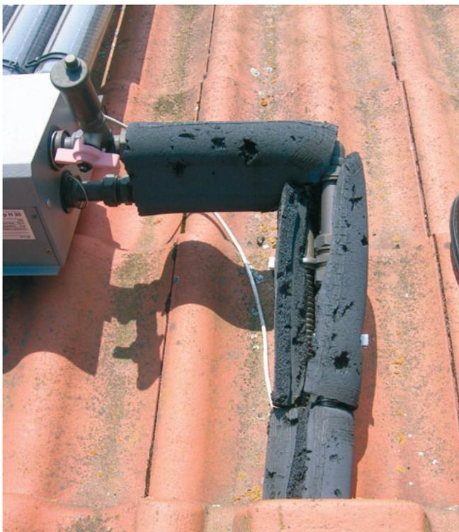
*Defektes Dämm-Material eignet sich nicht, um Wärmeverluste an Rohrleitungen zu begrenzen. Die Dämmung sollte alle Warmwasserrohre unversehrt und lückenlos umschließen und muss bei Solaranlagen außerdem hitzefest und für den Außenbereich geeignet sein.*
