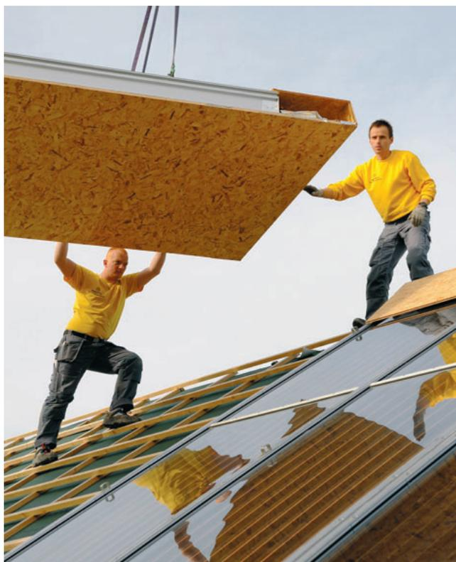
*Montage einer Indachanlage. Das Installationsunternehmen verantwortet, dass die Montage den statischen Anforderungen genügt und dass das Dach in seiner Dichtheit und Wetterschutzfunktion nicht beeinträchtigt wird.*
