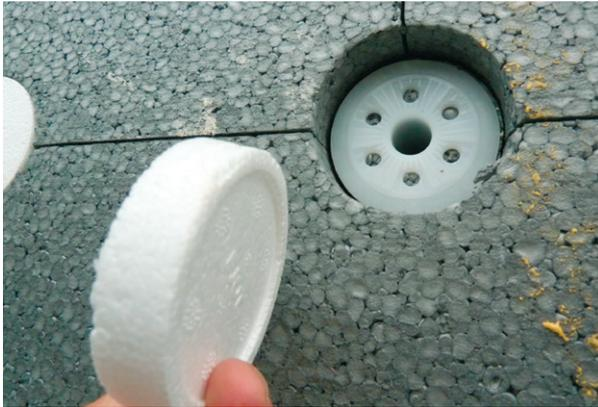
senkt und mit einer Dämmstoffscheibe abgedeckt oder es werden spezielle Dübel verwendet. So wird verhindert, dass sich der Dübelteller als Wärmebrücke später auf dem Deckputz optisch abzeichnet.
