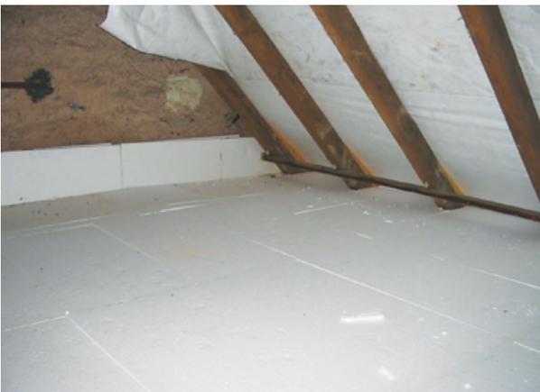
*Dachbodendämmung mit Flankendämmung an der Giebelwand.*
