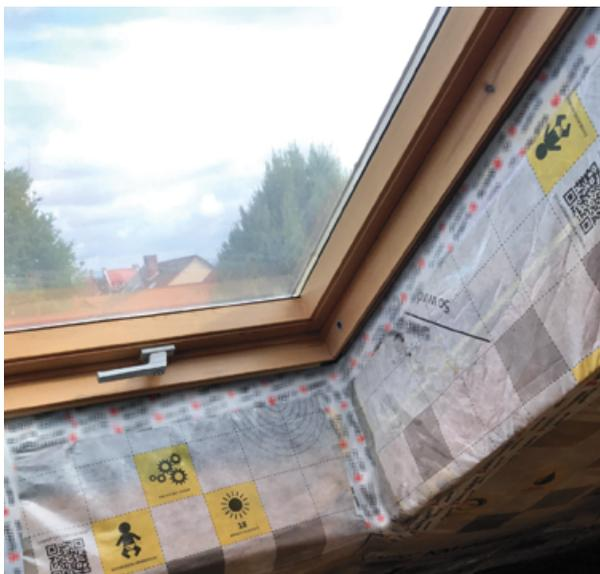
Die Folie ist dicht am Fenster angeschlossen.
