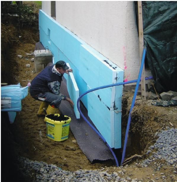
Die Perimeterdämmung wird angebracht
