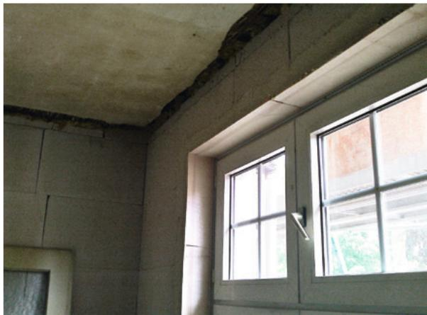
*Innendämmung aus Mineralschaumplatten mit Dämmung der Fensterleibungen*
