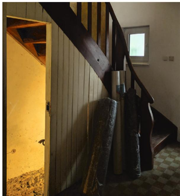
*Kellerabgang aus einer dünnen Holzkonstruktion unterhalb einer Holzterrasse – durch eine Dämmung können Wärmeverluste und Zugerscheinungen stark reduziert werden*
