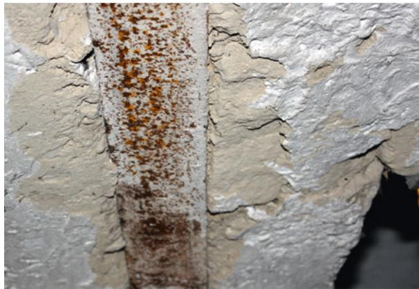
*Rostige Stahlträger in Deckenkonstruktionen deuten auf Feuchtigkeit hin. Hier muss überprüft werden, ob bereits die Statik der Decke beeinträchtigt ist!*
