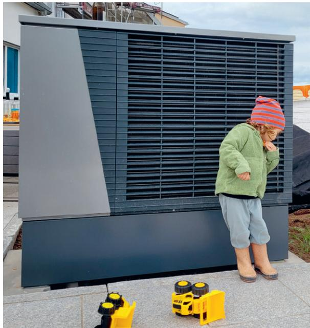
**i** Für 10 Kilowatt Entzugsleistung, die aus der Umwelt entnommen wird, braucht man etwa 4.000 Kubikmeter Luft pro Stunde.
