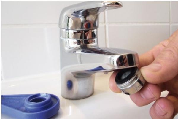
*So tauschen Sie einen Strahlregler aus: Schrauben Sie den alten Strahlregler einfach ab und ersetzen ihn durch einen sparsamen. Achten Sie dabei auf den Gewindedurchmesser und auf Innen- oder Außengewinde.*
