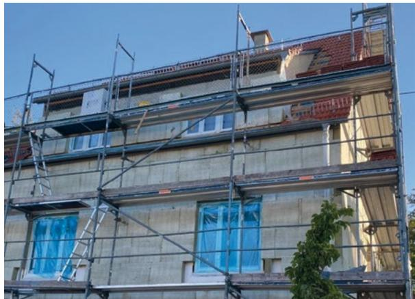
*Fassadendämmung mit einem Wärmedämmverbundsystem*
