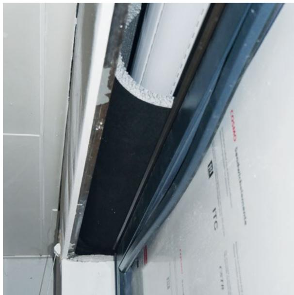
Für die nachträgliche Dämmung gibt es auch spezielle Formteile oder flexible Dämmplatten, die in den vorhandenen Kasten eingepasst und fixiert werden.
