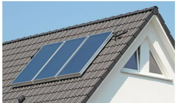
*Solarthermieanlage mit Flachkollektoren*
