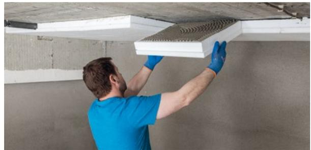
Kellerdeckendämmung mit Hartschaum-Dämmplatten
