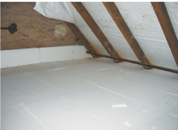
Dachbodendämmung mit Flankendämmung an der Giebelwand.
