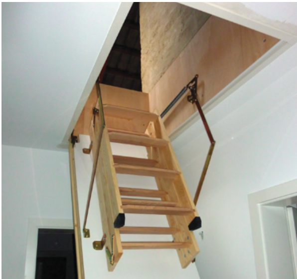
Eine neue, gedämmte Bodentreppe.
