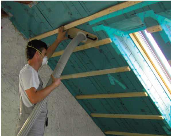
Der Dämmstoff wird eingeblasen.
