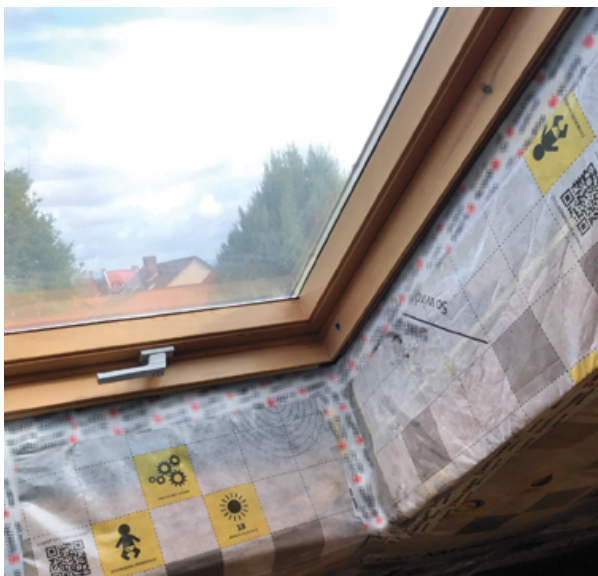
Die Folie ist dicht am Fenster angeschlossen.
