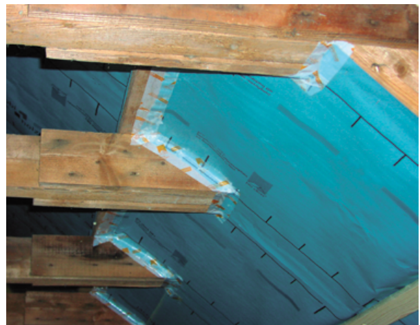
An jeden Balken muss dicht angeschlossen werden!
