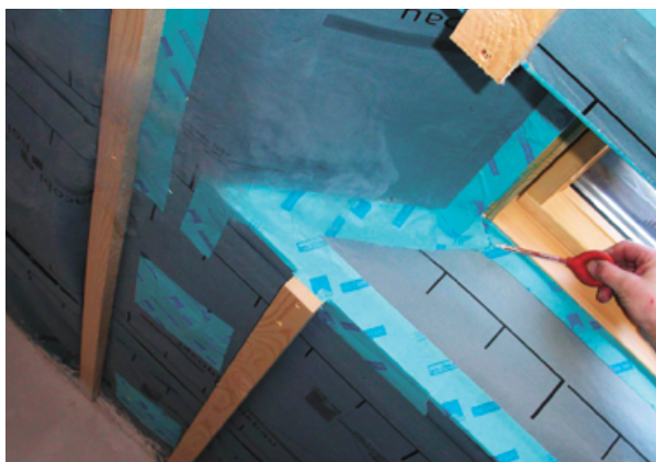
Die Dichtheit wird überprüft.
