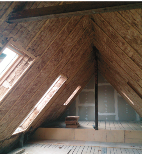
Zwischensparrendämmung mit Steinwolle
