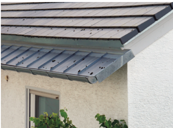
Ein neuer Dachüberstand aus Zinkblech.
