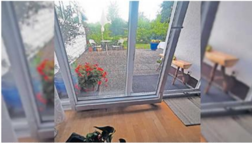
Hohe Schwellen wie bei dieser Tür sind das erste Hemmnis auf dem Weg zum barrierefreien Garten. FOTO: MIDE
